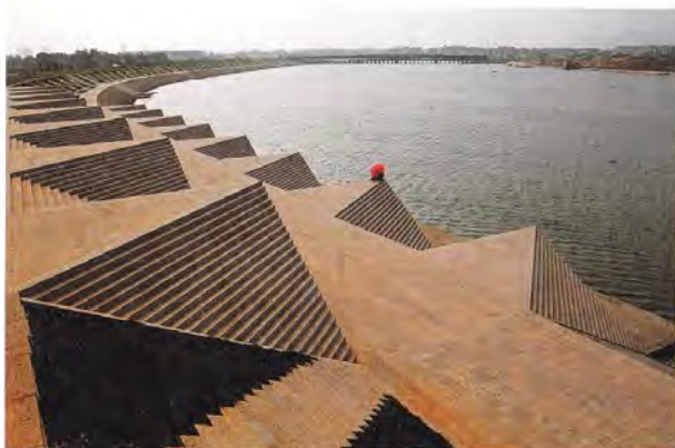
Hoogwaterkering Jinhuo Jindong Yiwu-rivier van architect Ai Weiwei.
